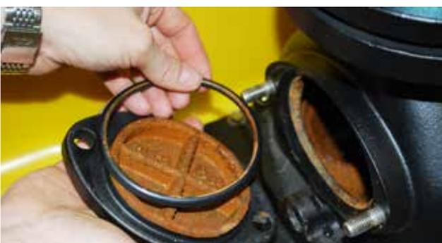
▶ Prüfung und Reinigung der Rückschlagklappe
