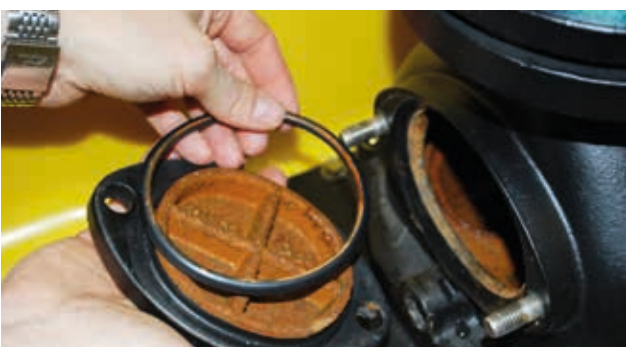
▶ Kontrola i czyszczenie klapy zwrotnej
