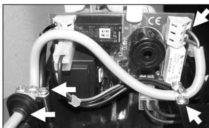
Il cavo di collegamento dell'allarme viene installato parallelamente al cavo di rete nell'alloggiamento della pompa di estrazione condensa. A tal fine si deve aprire la seconda apertura nel rivestimento
